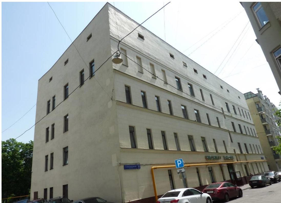
Рис. 3. Здание по адресу: г. Москва, Малый Николопесковский пер., д.8, главный фасад; Источник: фото Оценщика
